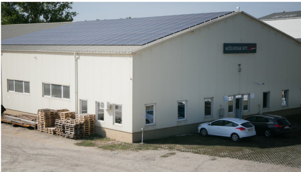
Kép: Az 50 kWp teljesítményű napeleme-rendszer az apostagi csarnoképület tetején.
